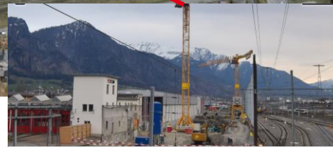
Neubau Werkstätten – Los 2
