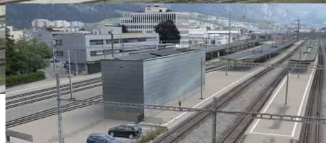
Gleisbau – Phase B
