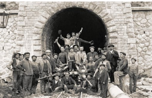
1902: Tunnelarbeiter am Portal Spinas
