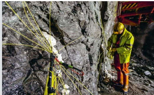
Sprengvortrieb im Albulagranit
