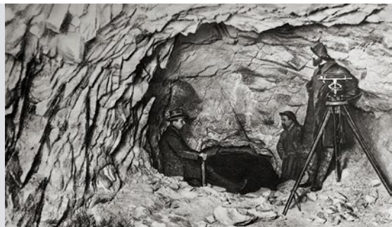
1902: Ingenieure beim Durchschlag im Albulatunnel
